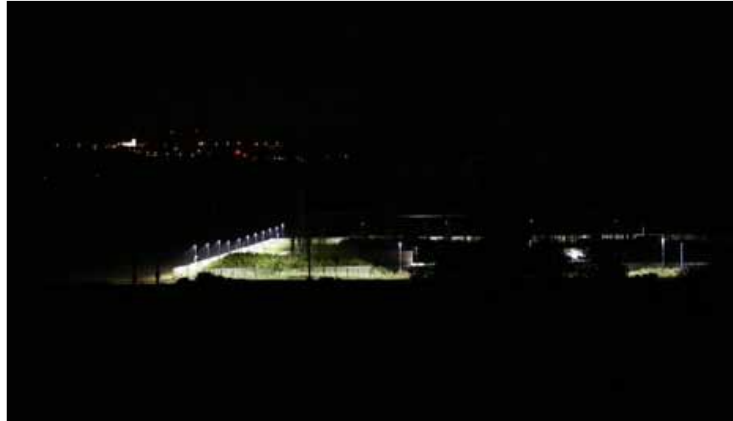
Obr.2 Pohled na rozvodnu R 420 kV TR Prosenice s rozsvíceným hlídacím osvětlením (noční osvětlení elektrické stanice pro kamerový dohled perimetru)
