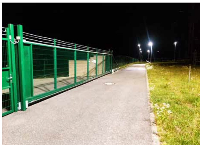
Obr.4 Osvětlení vjezdové brány do rozvodny R 245 kV TR Bezděčín
