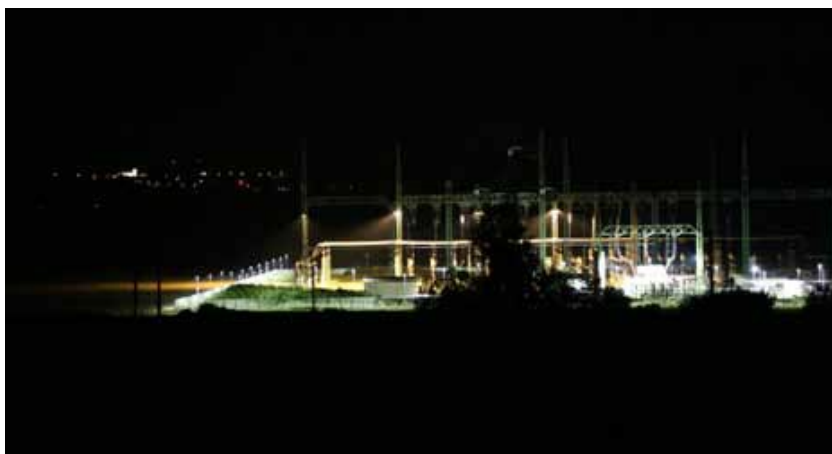
Obr.1 Pohled na rozvodnu R 420 kV TR Prosenice s rozsvíceným provozním a hlídacím osvětlením jen při mimořádné dálkové kontrole elektrické stanice
