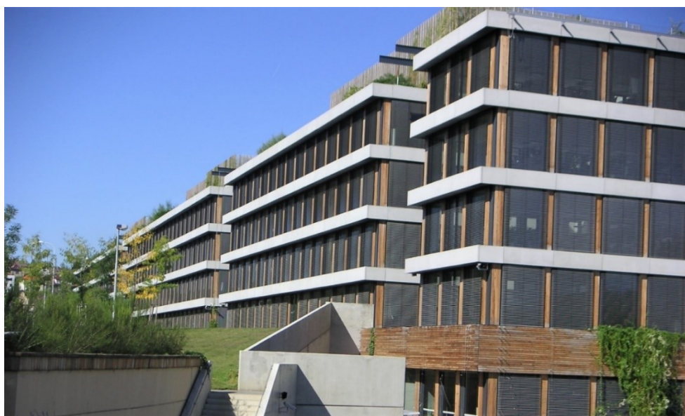
Obr. 2: Komplex budov s automatizovaným provozem venkovních žaluzií
